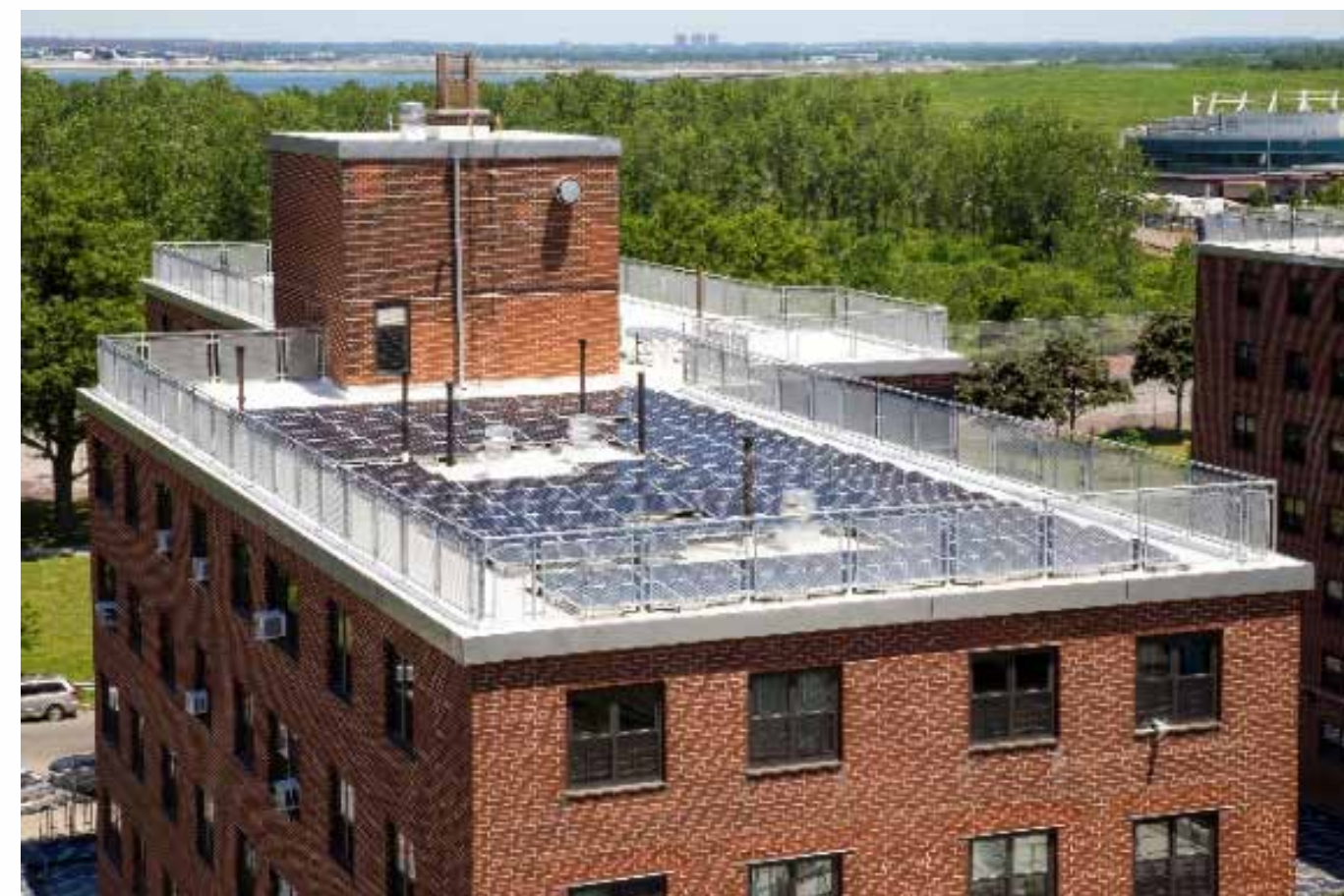
Reparación del tejado y del sistema de paneles solares en Ocean Bay (Bayside)
